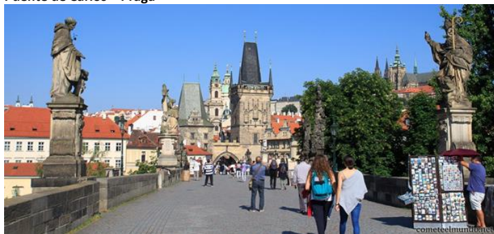
Puente de Carlos – Praga
